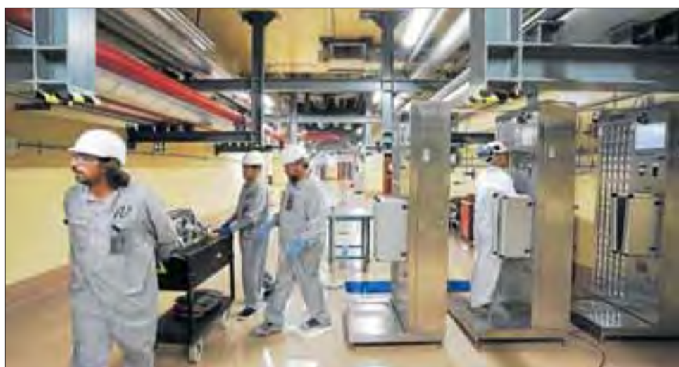
Los trabajadores tienen que pasar por siete arcos detectores de contaminación radiológica.
